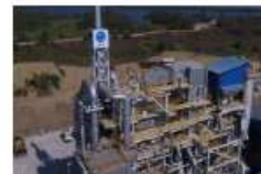
(例) 廃棄物発電施設
